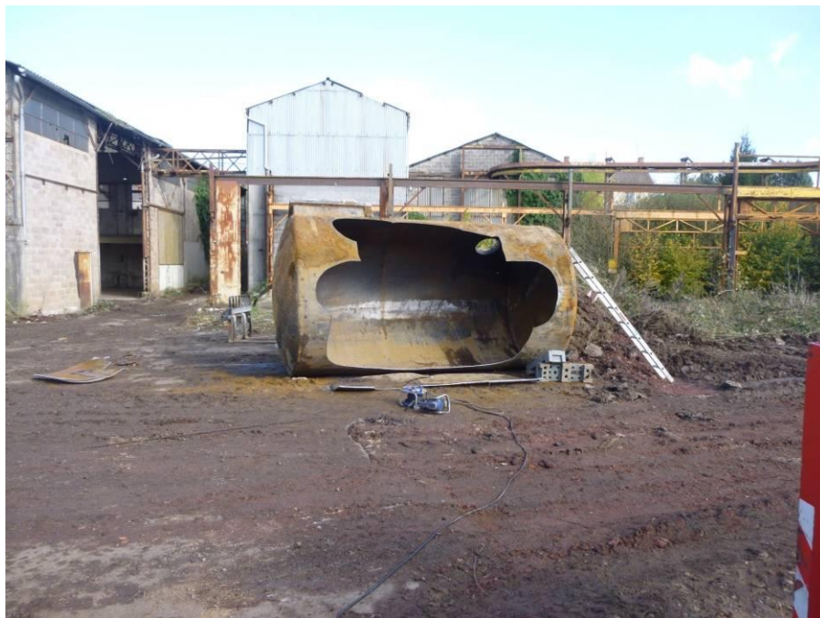
La cuve avant et en cours de découpe
