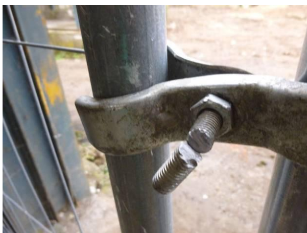
Détail du papillon de maintien des barrières Héras.
