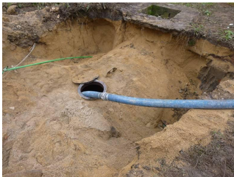
Le trou d'homme ouvert permet de la nettoyer et vidanger
