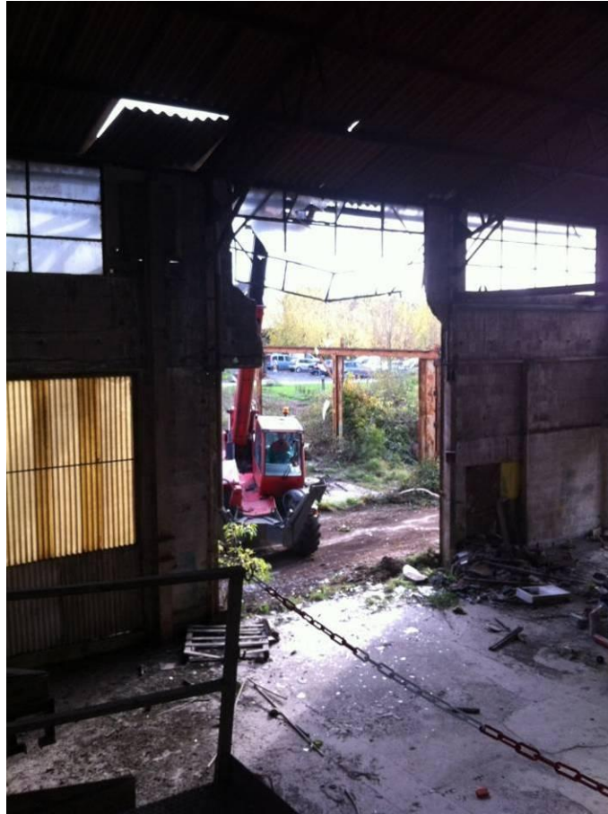
La sécurisation de la verrière
