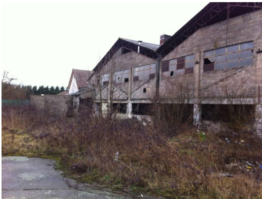
Photo du site : bâtiment 2
