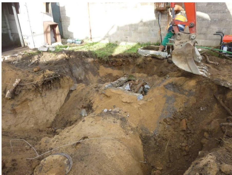
Mise à nue des tuyaux
