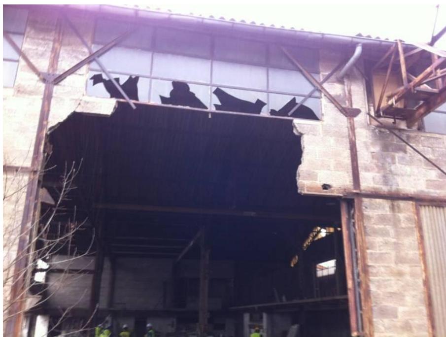
Le bâtiment 2 avant travaux
