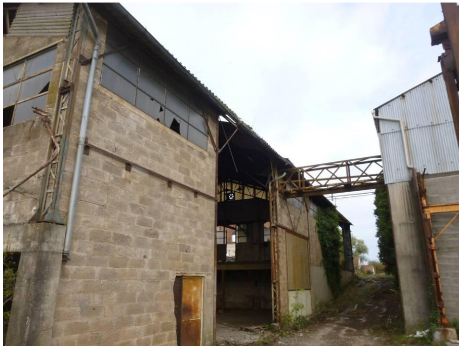
Le bâtiment 2 après sécurisation
